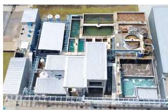
排水リサイクルプラント (MMTh)
