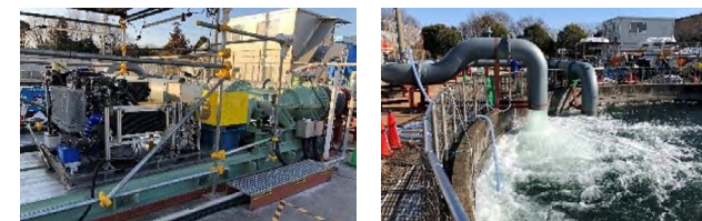
『デリカD:5』用エンジンを動力源として排水ポンプを駆動 実証試験時の排水の様子
