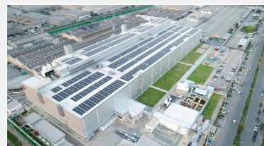
MMThの新塗装工場と太陽光発電設備
