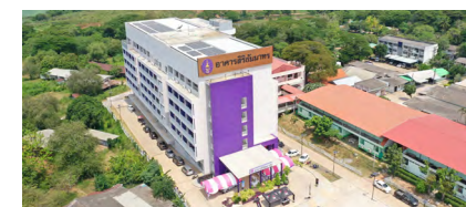
環境プロジェクト「Solar for Lives」太陽光発電設備を設置した病院
