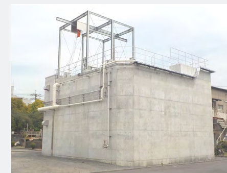
し尿・生活系排水処理施設 (水島製作所)
