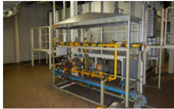
VOC排出抑制のための電着乾燥炉用脱臭装置(岡崎製作所)
