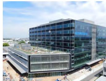
岡崎地区「開発本館」
