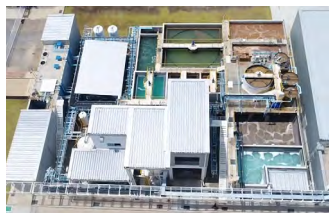
排水リサイクルプラント (MMTh)
