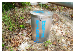
水質観測用井戸 (岡崎製作所)
