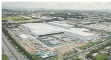
ラムチャバン工場内に建設中の第3工場 (2011年10月)
