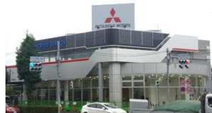
電動ドライブステーション
