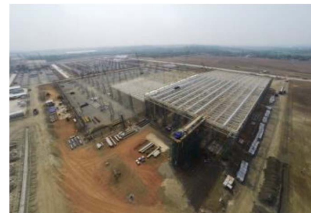
建設中のインドネシア新工場
