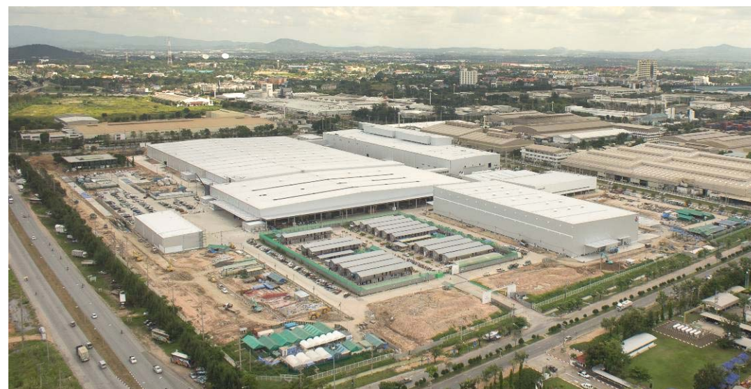
MMTh 建設中の新工場 (2011年10月)
