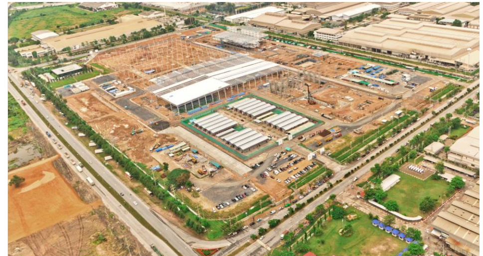
MMTh 建設中の新工場
